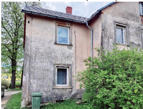
Attēls Nr. 162 Iekšpagalma fasādes kopskats. Iepriekš veikts plaisas remonts
