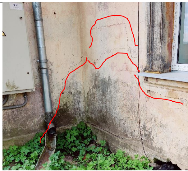
Attēls Nr. 17 – Plaisu tīkls ielas fasādes pusē zem 1.stāva loga
