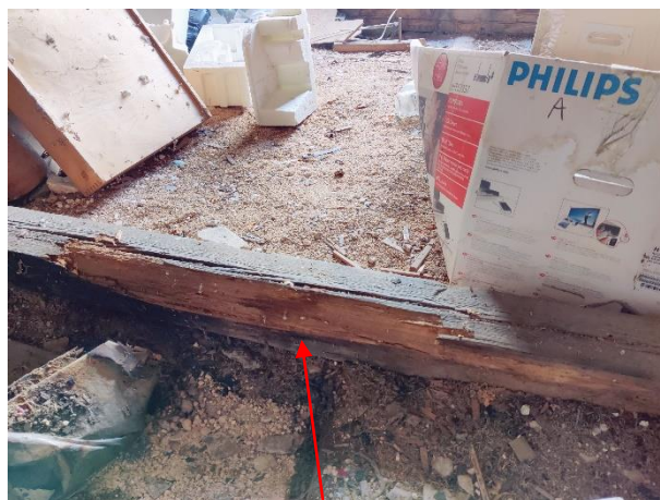
Attēls Nr. 71 Jumta krēsla sija zem antenas cauruma satrupējusi – to nepieciešams nomainīt!
