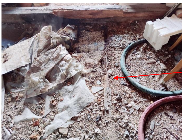
Attēls Nr. 72 Bēniņu pārseguma sija satrupējusi – to nepieciešams nomainīt!
