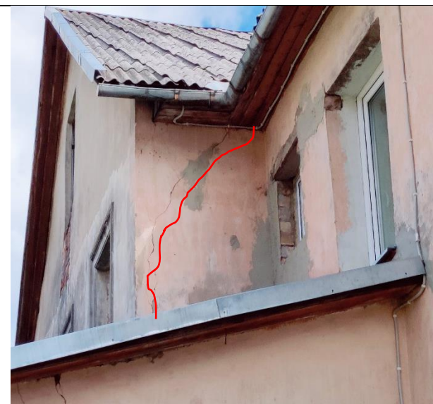
Attēls Nr. 9 – Diagonāla plaisa fasādes stūrī 2.stāva līmenī iekšpagalma pusē
