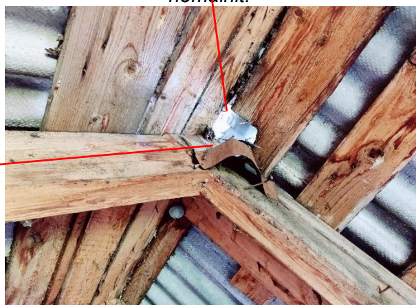
Attēls Nr. 73 Demontēta jumta antenas masta cauruma vietā ir satrupējusi pārseguma sija un jumta krēsla sija
