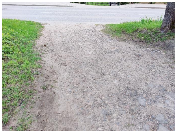
Attēls Nr. 8 Iebrauktuve no Jāņkalna ielas - grants un reciklēta asfalta maisījuma segums
