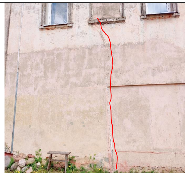
Attēls Nr. 6 – Gala sienas vidū iepriekš remontēta vertikāla plaisa līdz 2 stāva līmenim
