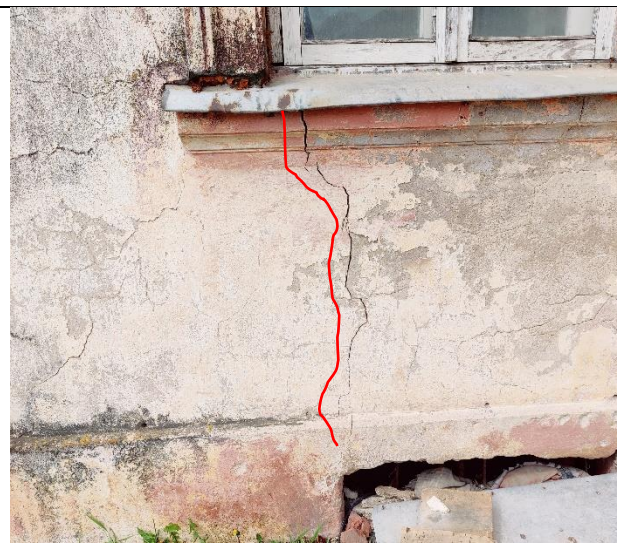
Attēls Nr. 21 – Plaisa ielas fasādes pusē zem 1.stāva loga
