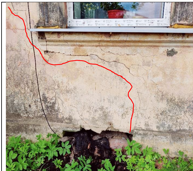
Attēls Nr. 16 – Plaisu tīkls ielas fasādes pusē zem 1.stāva loga
