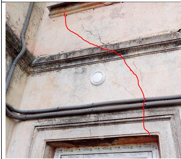
Attēls Nr. 19 – Plaisas (attēls Nr. 18) turpinājums starp 1. un 2.stāva logiem
