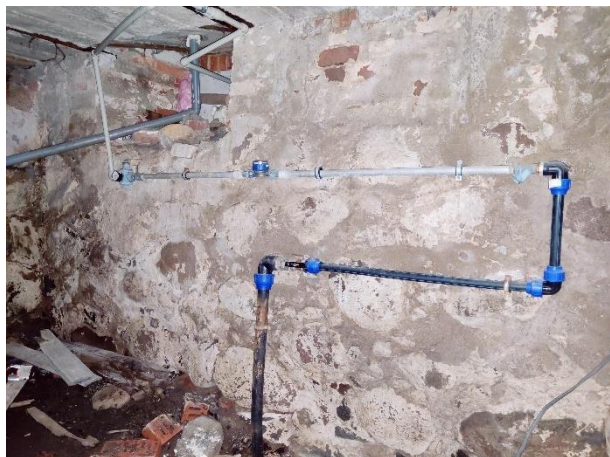
Attēls Nr. 175 Pagrabā atrodas aukstā ūdens ievads ar skaitītāju
