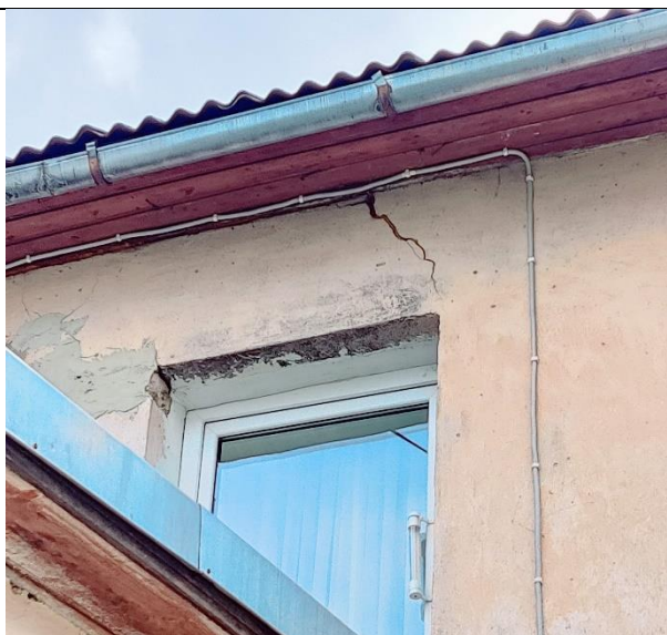
Attēls Nr. 8 – Plaisa iekšpagalma fasādes pusē 2.stāvā virs logailes
