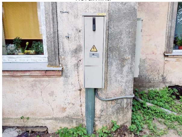
Attēls Nr. 206 Blakus atrodas elektrības ievadskapis pie fasādes
