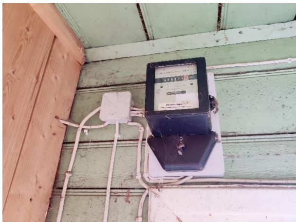
Attēls Nr. 201 Joprojām funkcionējošs vecā tipa elektrības skaitītājs
