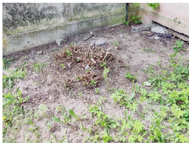
Attēls Nr. 23 Krūmu saknes nepieciešams pilnībā likvidēt – ilgtermiņā tiek bojātas ēkas norobežojošās konstrukcijas
