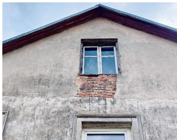
Attēls Nr. 161 Fasādes apmetums nodrupis zem bēniņu loga
