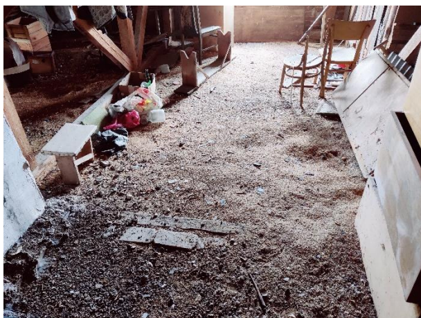
Attēls Nr. 70 Bēniņu pārseguma kopskats. Izmantots skaidu un izdedžu maisījums
