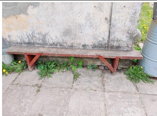
Attēls Nr. 25 Koka sols pie iekšpagalma ieejas – tā aizsargkrāsojums pilnībā nolietojies
