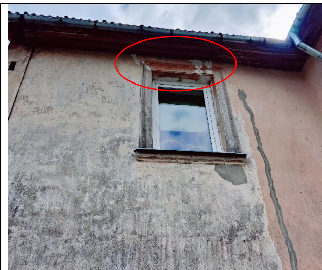
Attēls Nr. 12 – Iekšpagalma fasādes 2.stāva logailei trīs plaisas, kas iepriekš remontētas jau
