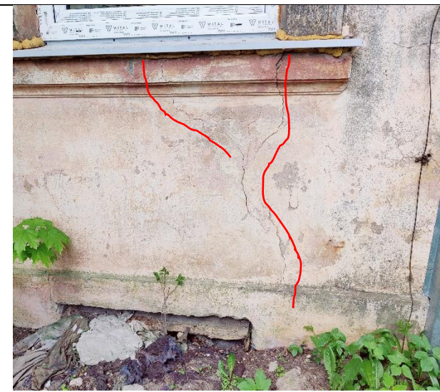
Attēls Nr. 18 – Plaisa ielas fasādes pusē zem 1.stāva loga
