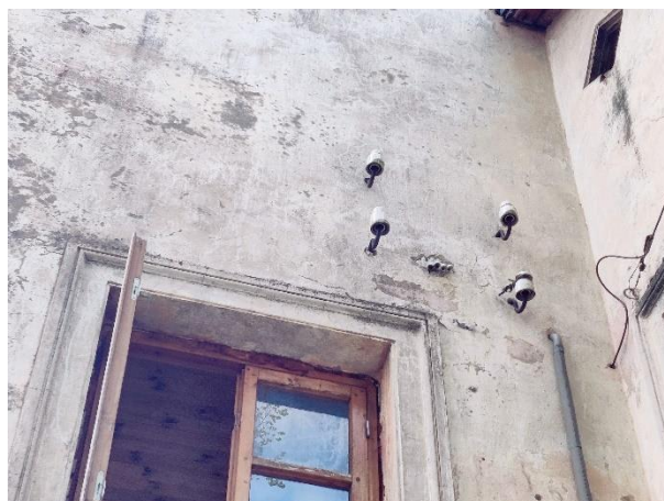
Attēls Nr. 204 Uz fasādes saglabājušies gaisvadu elektrolīnijas enkuri ar izolējošo keramiku
