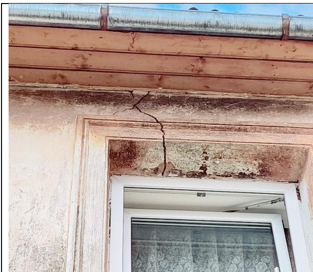
Attēls Nr. 22 – Plaisa ielas fasādes pusē virs 2.stāva logailes
