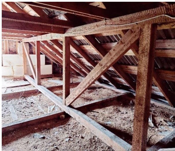
Attēls Nr. 77 Nesošo koka konstrukciju kopskats. Nesošās koka konstrukcijas ir apmierinošā stāvoklī
