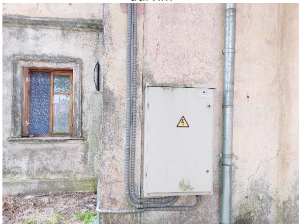
Attēls Nr. 205 Galvenā sadalne uz fasādes
