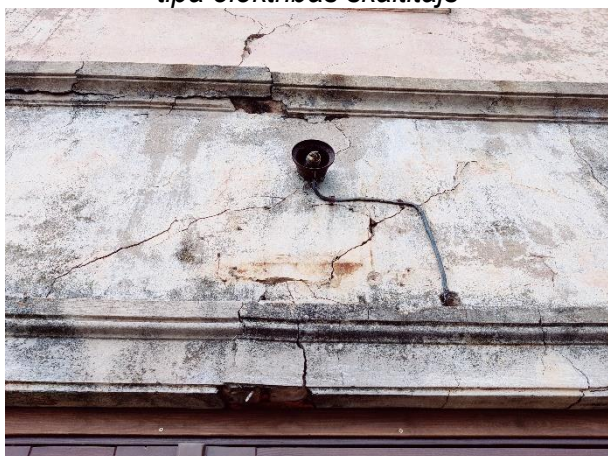
Attēls Nr. 203 Nefunkcionējošs āra apgaismojuma elements virs galvenās ieejas durvīm
