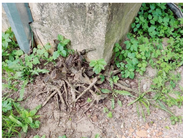
Attēls Nr. 22 Krūmu saknes nepieciešams pilnībā likvidēt – ilgtermiņā tiek bojātas ēkas norobežojošās konstrukcijas
