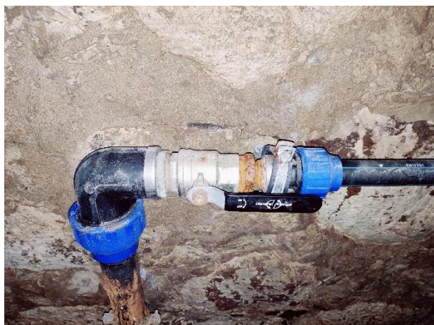
Attēls Nr. 177 Ventilis aukstā ūdens caurulei ir funkcionālā darba kārtībā
