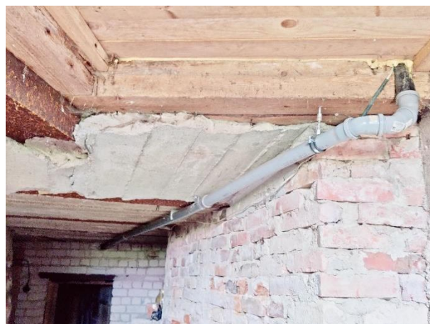
Attēls Nr. 180 Dzīvoklim ierīkota sadzīves kanalizācijas caurule
