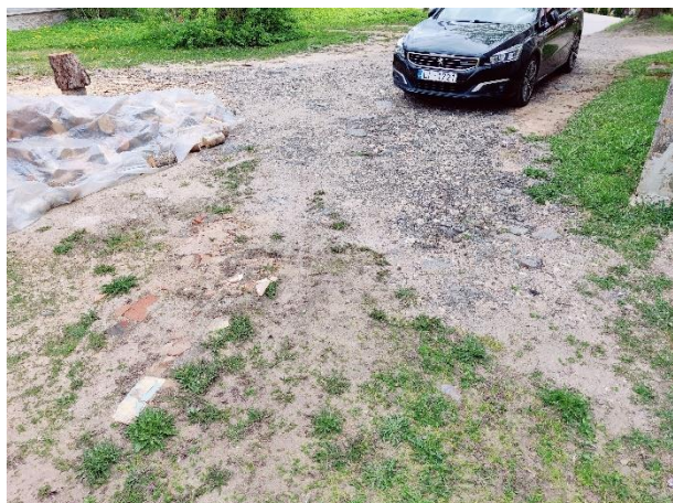
Attēls Nr. 7 Reciklēta asfalta seguma automašīnu novietošanas laukums šķūņa priekšā
