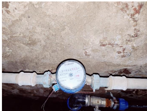
Attēls Nr. 176 Aukstā ūdens patēriņa skaitītājs, plombe nav bojāta
